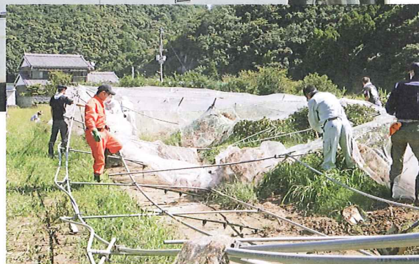
台風12号災害復興支援(和歌山県古座川町) 農業体験研修所の、泥をかぶったネットの撤去(9/23撮影)
